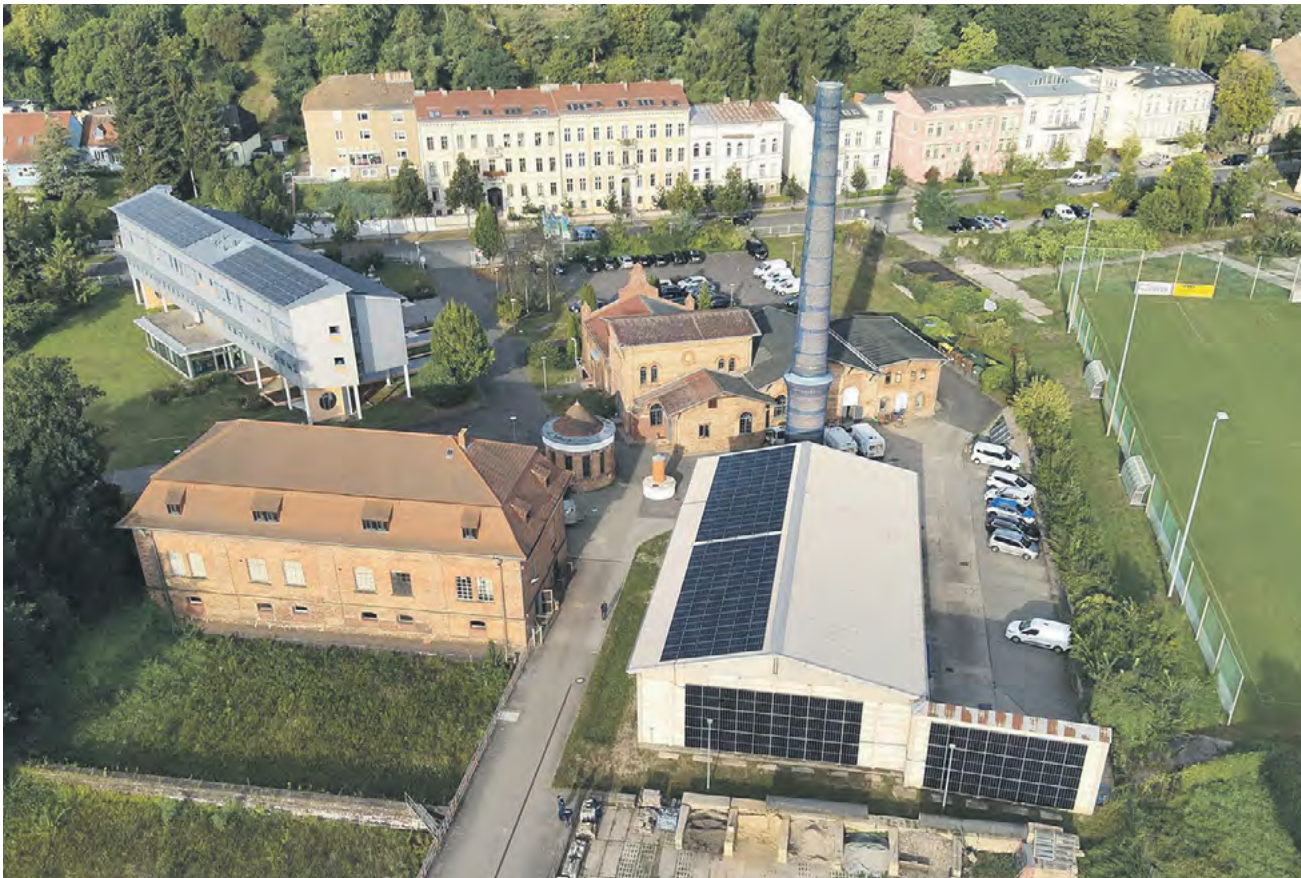
Photovoltaikanlagen auf den Gebäuden am FWA-Verwaltungssitz liefern Strom für die Firmenzentrale am Buschmühlenweg.
