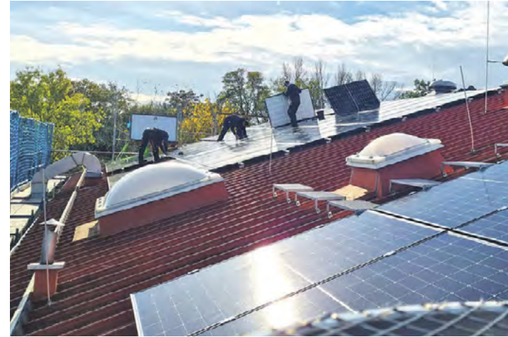
Montage der PV-Module auf der Kläranlage am Mittelweg.
