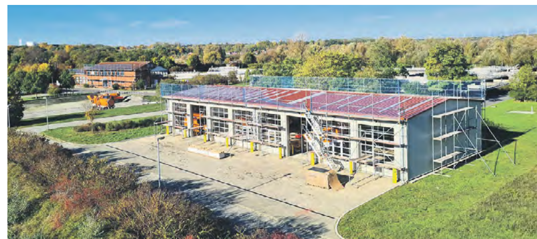
Etwa 40 % der Sonnenenergie von der Kläranlage können ins öffentliche Stromnetz gespeist werden.
