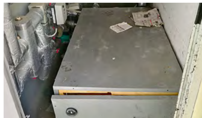
Völlig verbaut ist dieser Zähler ebenfalls nicht erreichbar für die Kollegen.
