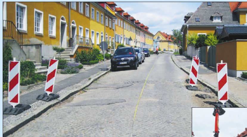
Es wird eng: Eine umfangreiche Baumaßnahme wie die Kanalsanierung in der Nußnervorstadt erfordert vom Bauausführenden genaue Planung und Koordination. Anwohner brauchen starke Nerven und einen langen Atem.
