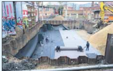
Die Baugrube war bis zu vier Meter tief, 33 Meter lang und 20 Meter breit.
