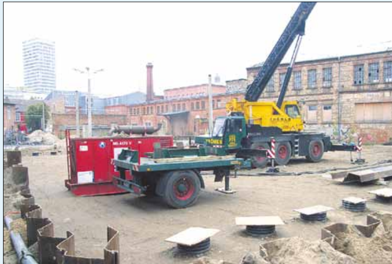
Die Bauarbeiten am Regenrückhaltebecken wurden Mitte November abgeschlossen.
