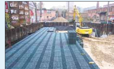
2.000 Kunststoffteile wurden eingebaut. Das von der Stadt finanzierte Becken kann bis zu 800 m³ Wasser aufnehmen.
