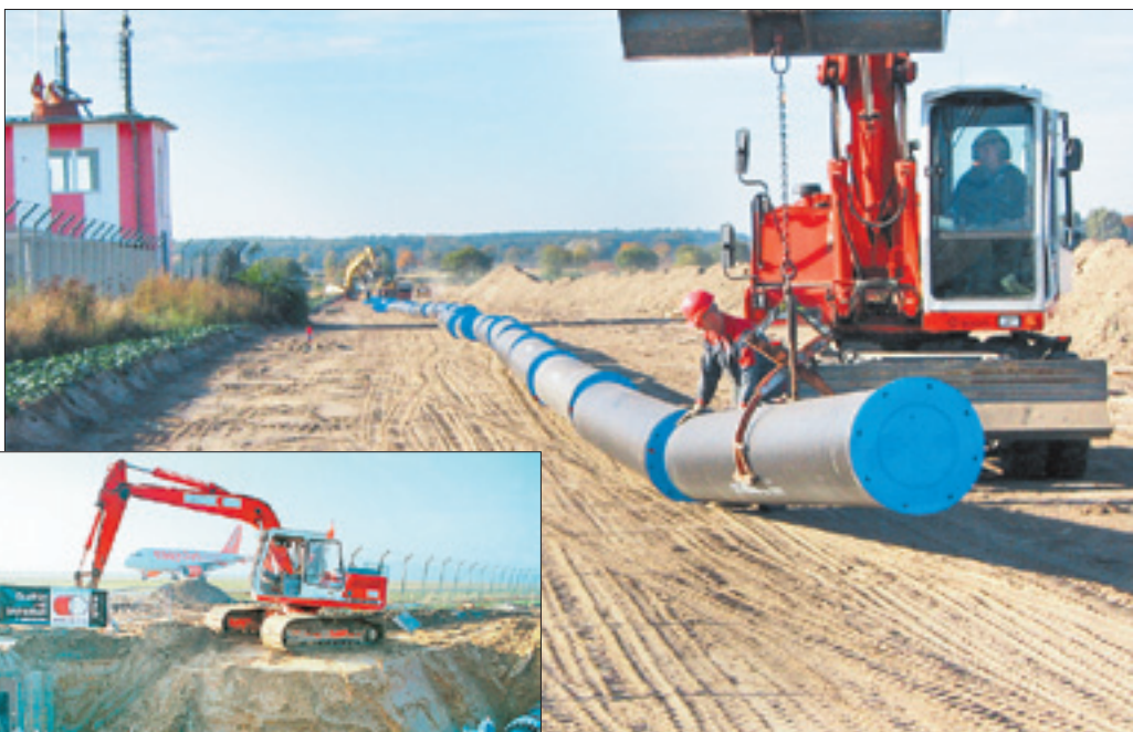
RAKW-Spezialisten verlegen am Rande des Flughafens Schönefeld eine Trinkwasserleitung.
