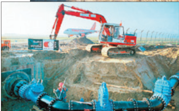
Am Flughafen BBI wird ein Leitungsknoten montiert.
