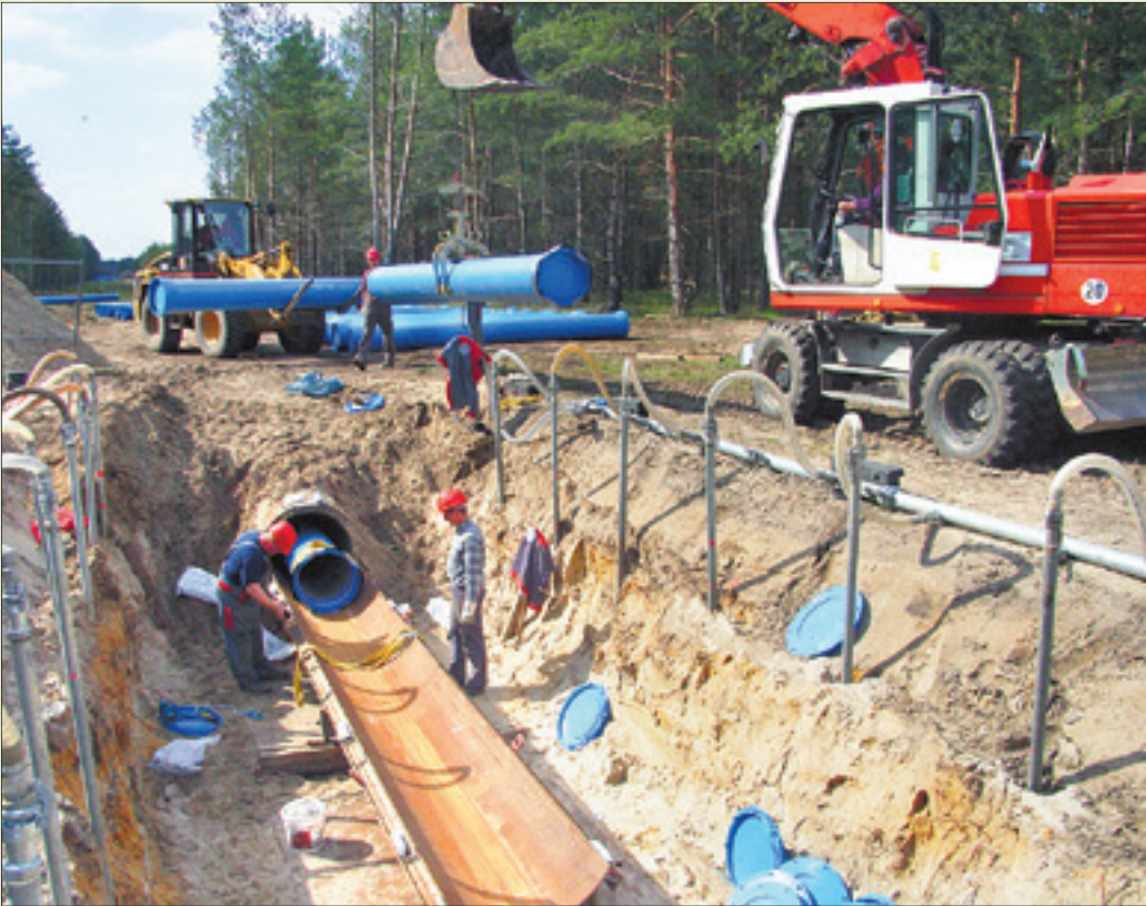
Die Rohrleitungsspezialisten vom RAKW ziehen ein neues Rohr in die alte Trinkwasserleitung.
