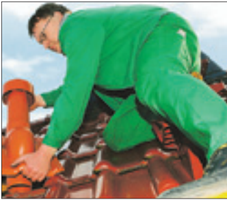
Dachentlüftungen müssen vom Fachmann installiert werden. Infos gibt die FWA.
