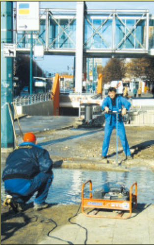
Im Auftrag des FWA: Reparatur eines Rohrbruchs.
