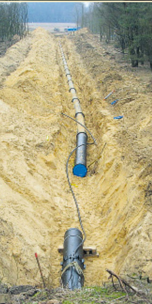
Die Trinkwasserfernleitung in ihrem neuen Bett.
