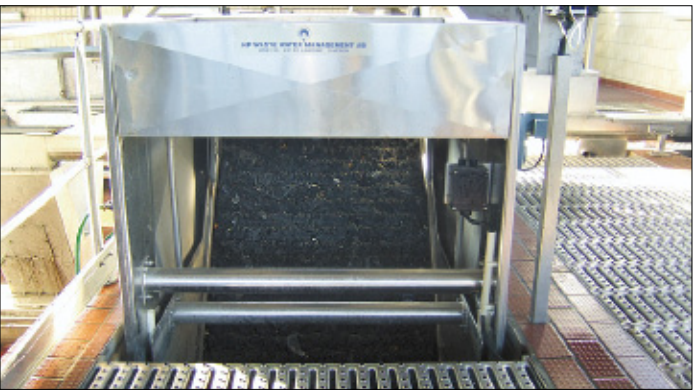
Dieser Rechen filtert die Abfälle aus dem Schmutzwasser.
