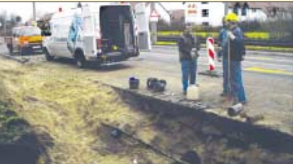
Henry Löpert und Norbert Schubbel arbeiten an der Trinkwasserleitung in Markendorf.
