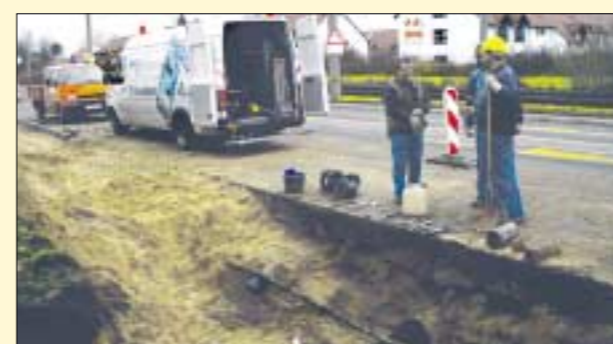
Henry Löpert und Norbert Schubel arbeiten an der Trinkwasserleitung in Markendorf.
