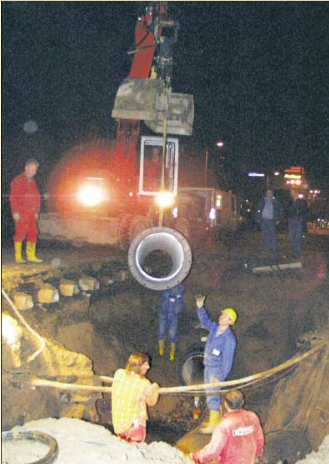
Am späten Abend wird das neue Rohr eingepasst.
