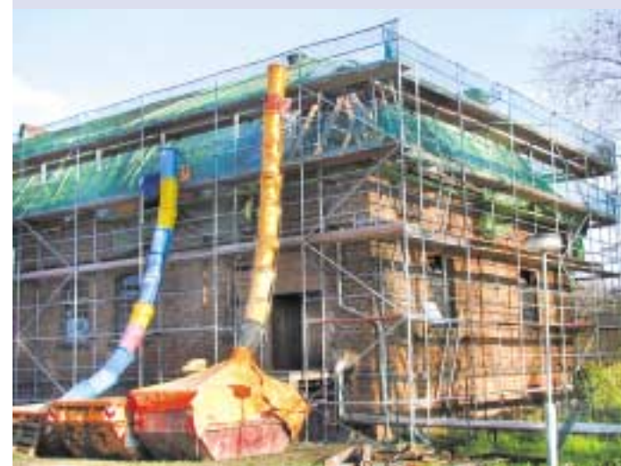
Die Arbeiten an der Dachsanierung des ehemaligen Enteisungshauses, das in den Jahren 1925–1926 errichtet wurde, gehen zügig voran.
