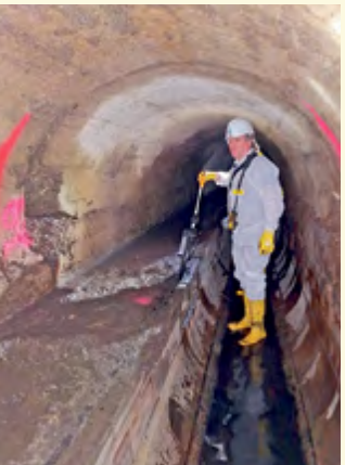
Die Tragfähigkeit des Kanals musste neu ermittelt werden. Hier wurden Probebohrungen für statische Berechnungen markiert.
