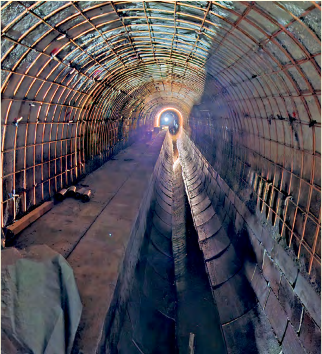
Bevor der Kanal mit Spritzbeton beschichtet werden kann, wurden Bewehrungsmatten montiert.
