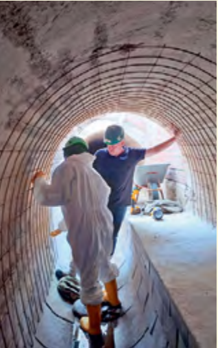
Meter für Meter befestigen die Arbeiter Bewehrungsmatten im Oval des alten Abwasserkanals.
