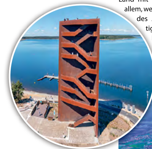
Der „Rostige Nagel“ ragt an der Mündung des Sornoer Kanals zum Sedlitzer See in den Himmel.
