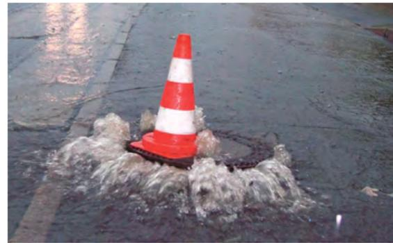
Nichts läuft mehr: Wenn zu viel Regenwasser im Schmutzwasserkanal landet, entsteht ein Rückstau, weil Kanäle und Pumpen überlastet sind. Das Abwasser dringt dann aus Pumpwerken und Schachtdeckungen (unten).
