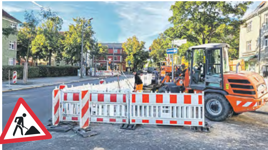
In der Rathenaustraße baut die FWA an Trink- und an Abwasserleitungen.
