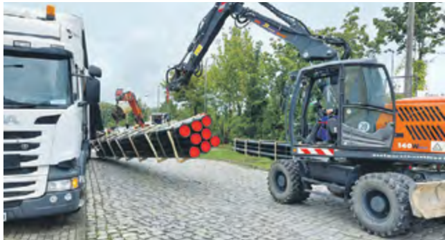
Anlieferung neuer Abwasserrohre.
