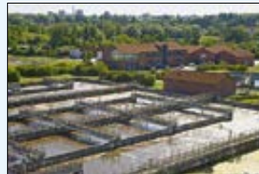
Die drei Belüftungsbecken erhalten bei laufendem Betrieb eine neue Flächenbelüftung.
