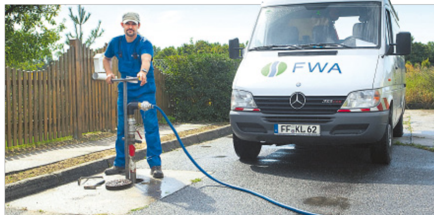
In der Hohenwalder Straße wird jeden Monat gespült. Rohrnetz-Kollege Thomas Berndt leitet das Spülwasser aus dem Hydranten ab.
