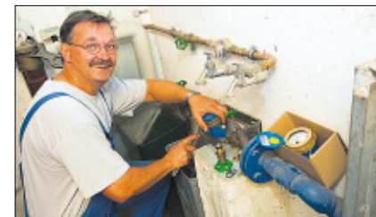
Torsten Bernstein wechselt einen Zähler im FWA-Versorgungsgebiet. Die Größe des Zählers richtet sich nach bundesweiten Bestimmungen.
