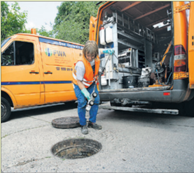
Ab in die Versenkung: Kanalarbeiter Andreas Fechner schickt das kleine Hightech-Gerät auf seinen unterirdischen Arbeitseinsatz in die Kanalisation.
