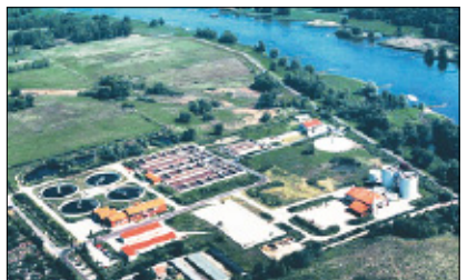
Die Frankfurter Kläranlage in Sichtweite zur Oder.
