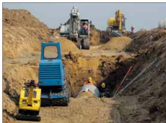
Auch 15 km Trinkwasserleitung sind kein Problem. (Tesch)
