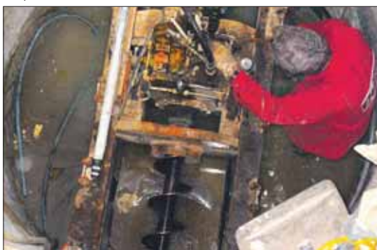
Der unterirdische Vortrieb wird vorbereitet. (DBG)
