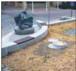
Schieber in der Logenstraße
