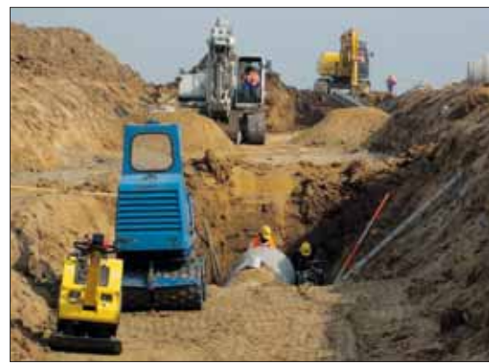
Auch 15 km Trinkwasserleitung sind kein Problem. (Tesch)
