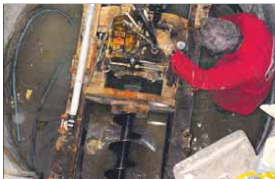
Der unterirdische Vortrieb wird vorbereitet. (DBG)
