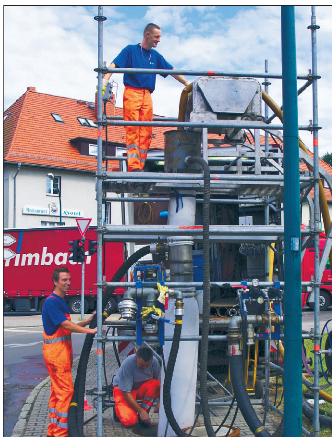
Fürstenwalder Poststraße: Der Strang wird ausgehärtet.
