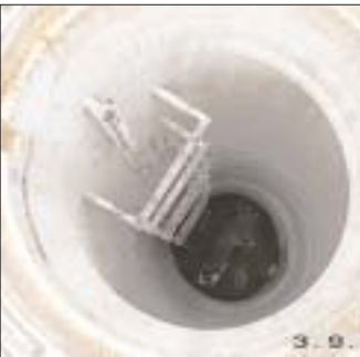
Abwasserschächte vor und nach der Sanierung
