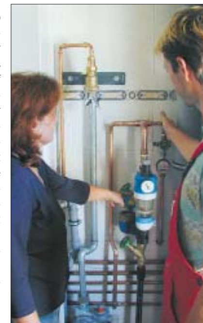
Hier wurden Kupferrohre für die Hausinstallation eingesetzt.
