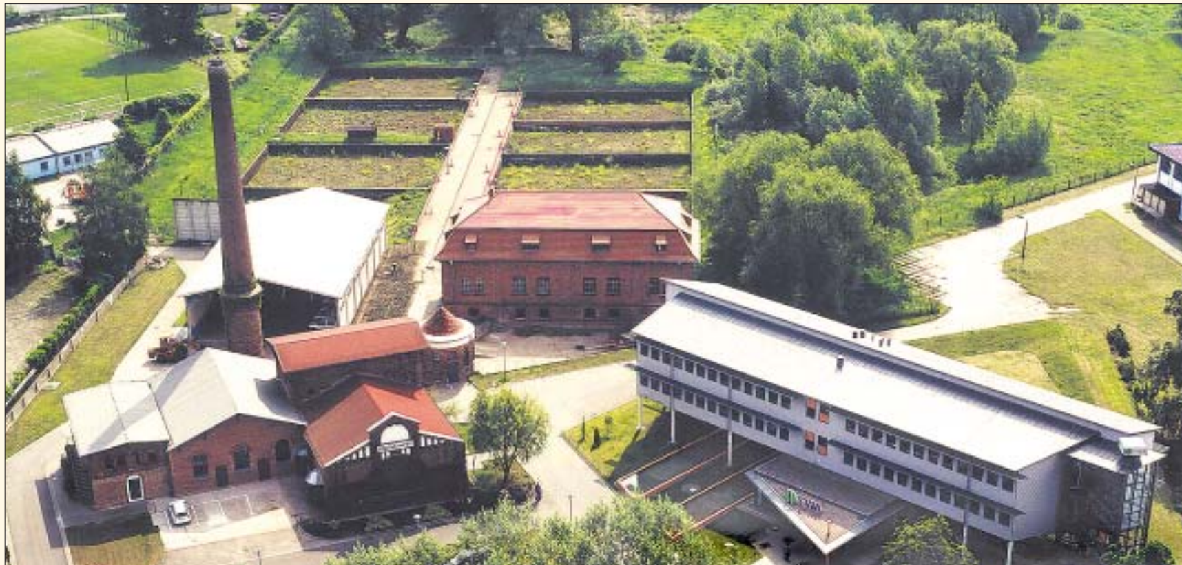
Die FWA am Frankfurter Buschmühlenweg aus luftiger Höhe. Die Sanierung der alten Gebäude geht zügig voran.
