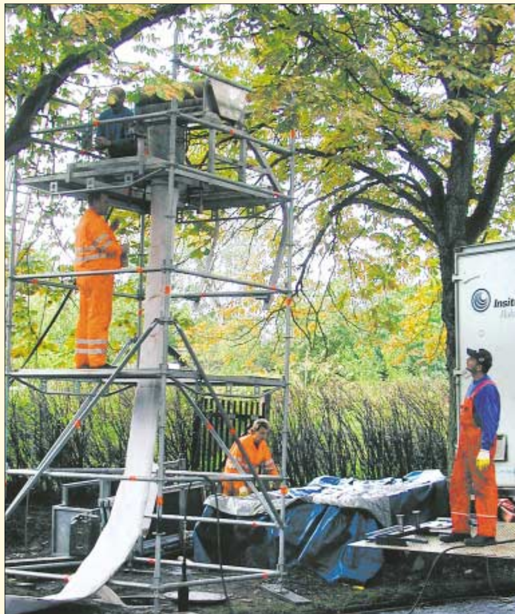
Über diesen fast 4 m hohen Turm gleitet der Schlauch in die alte Kanalaröhre.
