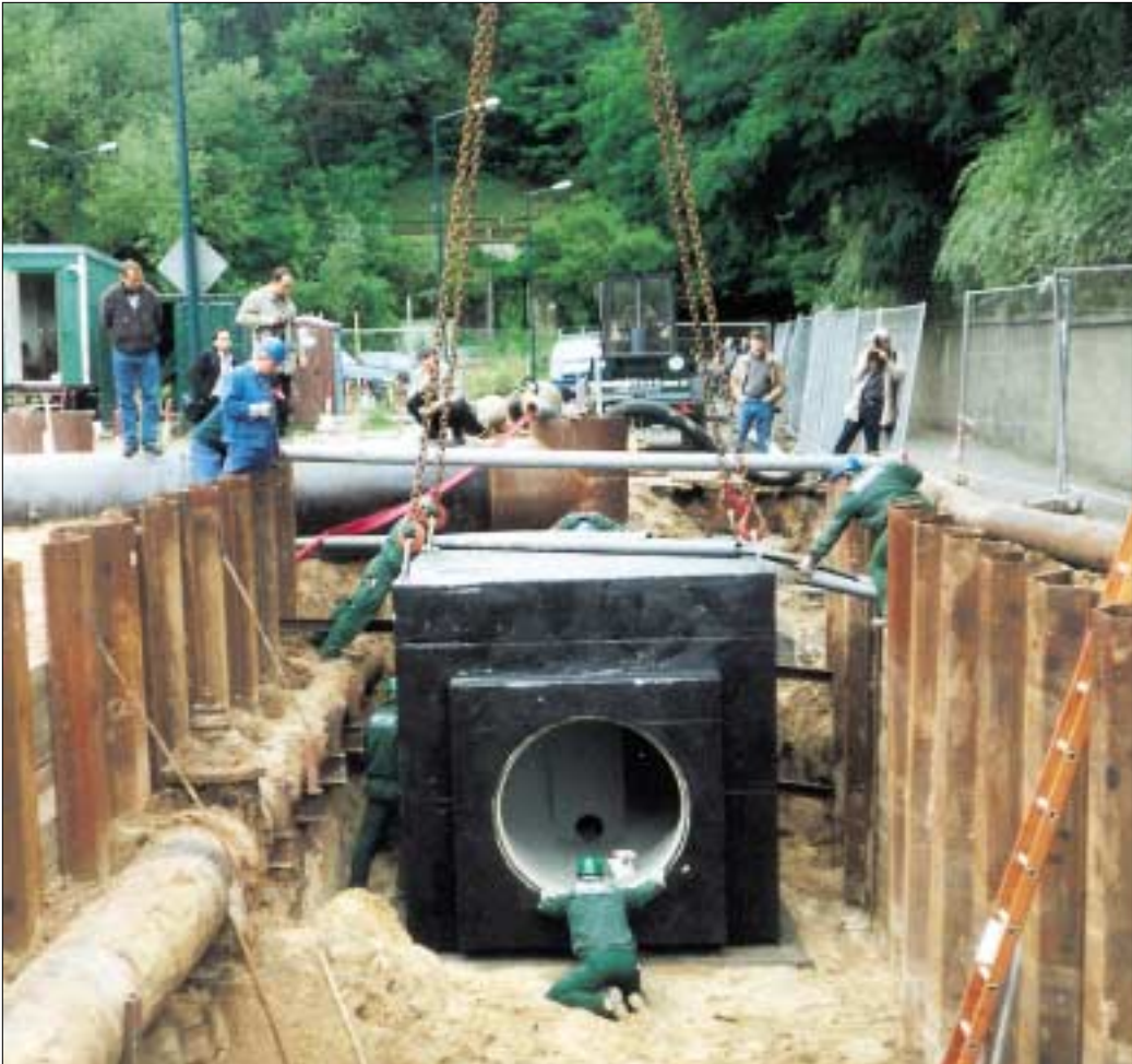
Bau des Entlastungs- und Überlaufwerkes für Abwasser in der Großen Müllroser Straße. Mit Fingerspitzengefühl wird das 42 Tonnen schwere Bauwerk in die Grube bugsirt. (Foto oben)
