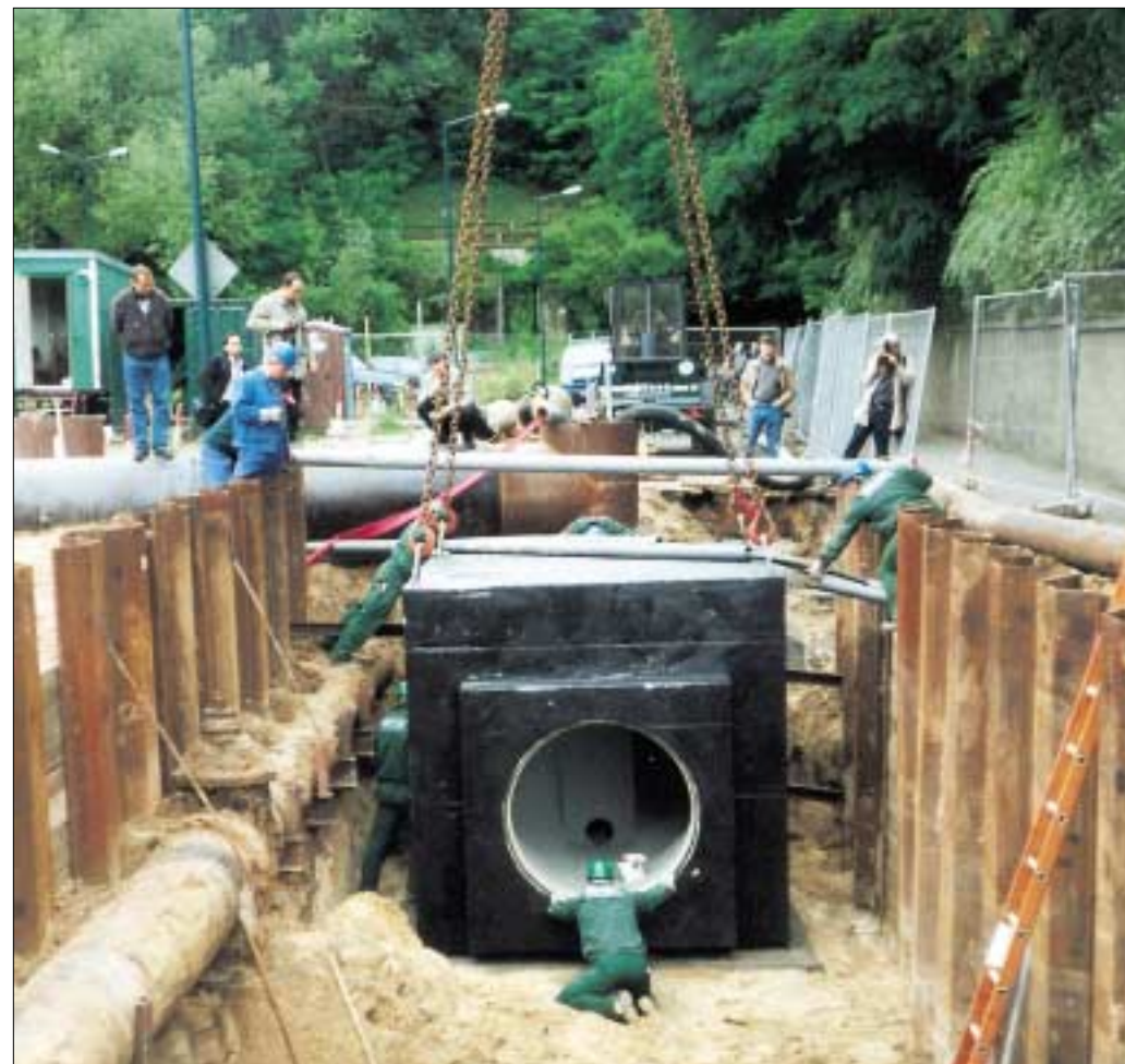
Bau des Entlastungs- und Überlaufwerkes für Abwasser in der Großen Müllroser Straße. Mit Fingerspitzengefühl wird das 42 Tonnen schwere Bauwerk in die Grube bugsiert. (Foto oben)
