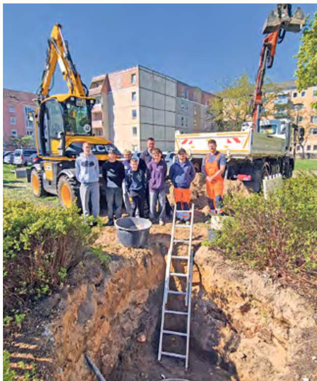
Die Baustelle in der Spornmachergasse war nur einer von vielen spannenden Stopps beim Zukunftstag der FWA.
