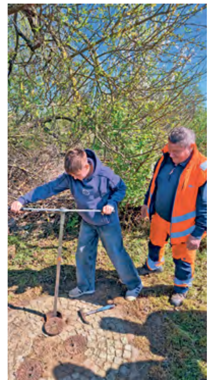
Gar nicht so einfach: im Trinkwassernetz einen Schieber mit einem Schieberkreuz zu bewegen.
