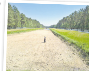
Infiltrationsbecken aus der Vogelperspektive (oben) und nach der Sanierung (unten).
