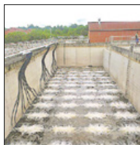
Neue Flächenbelüfter sind langlebiger und energieeffizienter.
