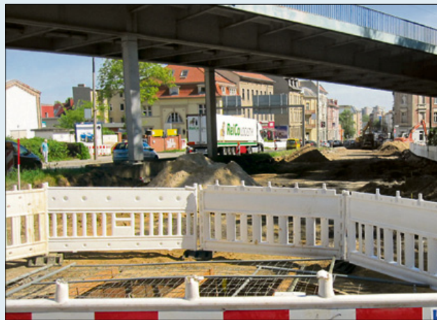
Das unvermeidbare Baustellenchaos muss es dank Koordination von „Wasser und Straße“ nur einmal geben.
