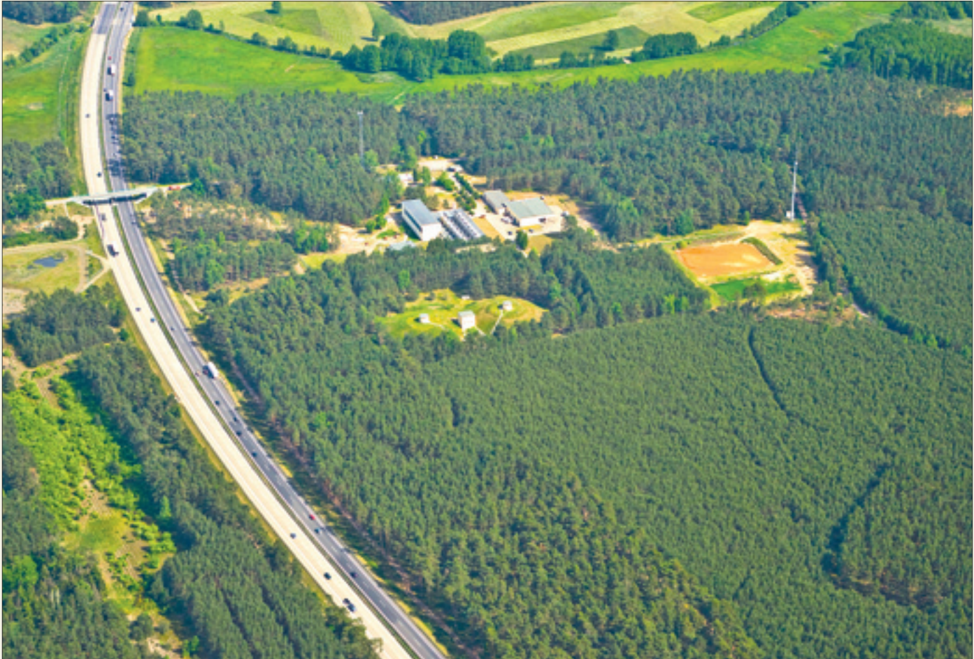
Wasserschutzgebiet rund um das Wasserwerk Briesen: Hier wird jeden Monat das Pegelnetz des umliegenden Trinkwasser-Einzugsgebiets kontrolliert.
