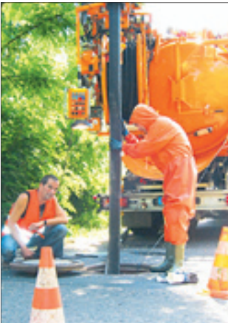
Aufwändig ist die Beseitigung einer Verstopfung im Hauptkanal.
