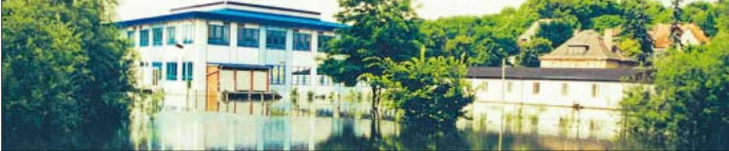
Land unter im Bereich des FWA-Geländes, für die Anwohner wurden Stege errichtet (links).
