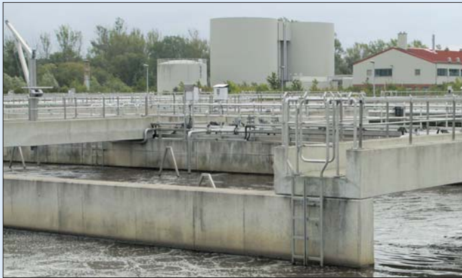
Fast 12 % weniger Abwasser floss 2003 in die Kläranlage.
