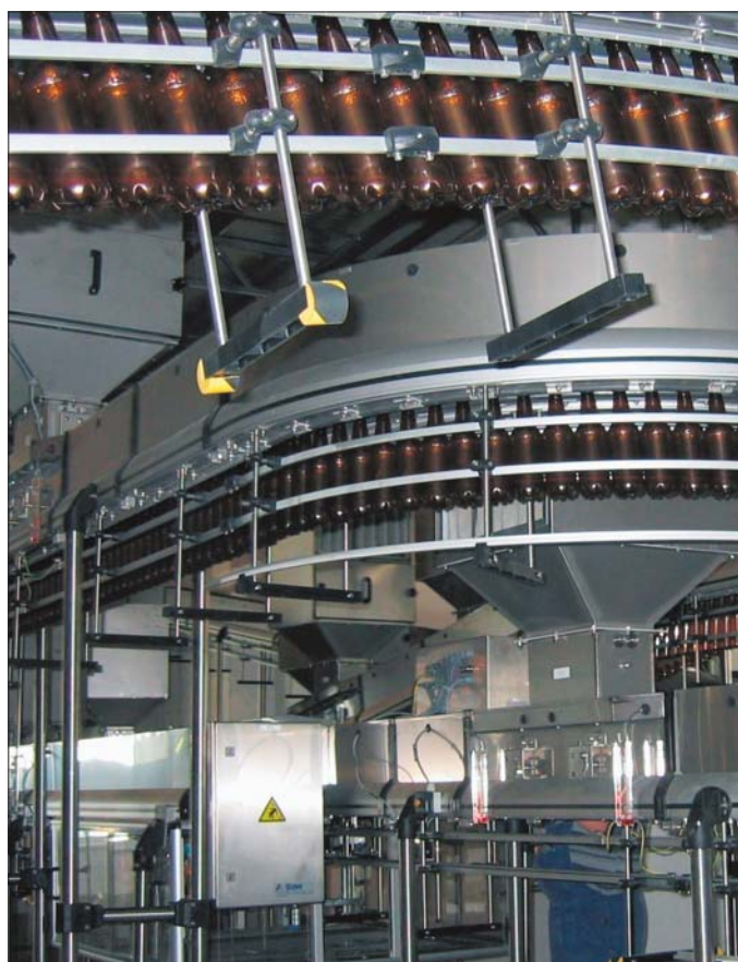
Die PET-Flaschen-Abfüllanlage ging kürzlich in Betrieb.
