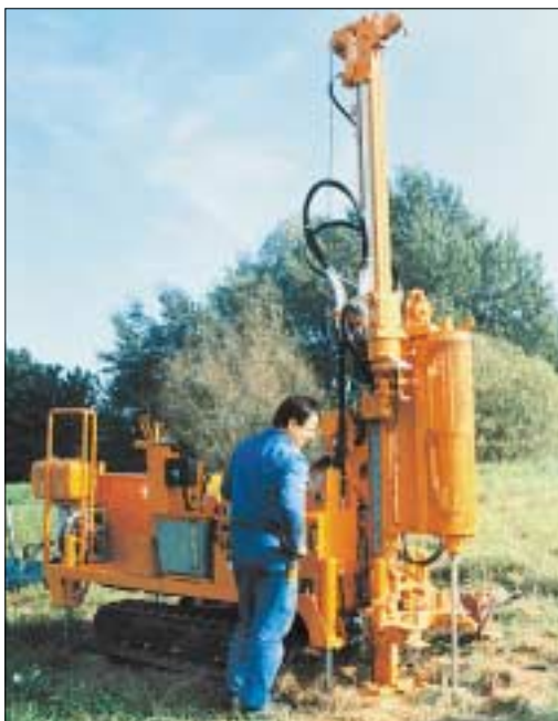
Für Baugrunduntersuchungen wird häufig ein Rammkernsondierungsgerät eingesetzt
