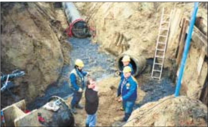
Umbindung des neuen Teilstücks (links im Bild) an die Hauptleitung
