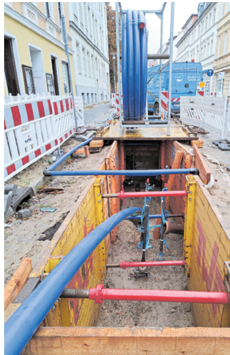
Beim sogenannten Berstlining-Verfahren werden, wie hier in der Dresdener Straße, neue Trinkwasserleitungen weitgehend ohne Graben in alte Leitungen eingezogen. Fotos (2): FWA
