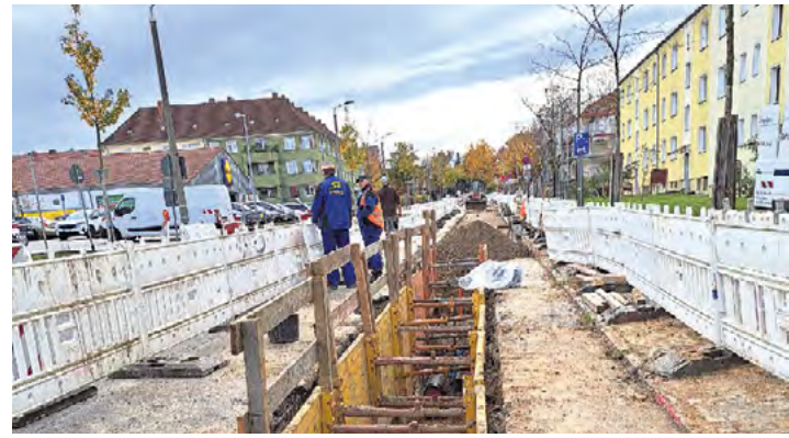
In der Rathenastraße werden Trink- und Abwasserleitungen verlegt. Foto: FWA
