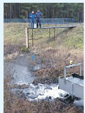
Pumpen befördern Spreewasser in vier riesige Infiltrationsbecken.
