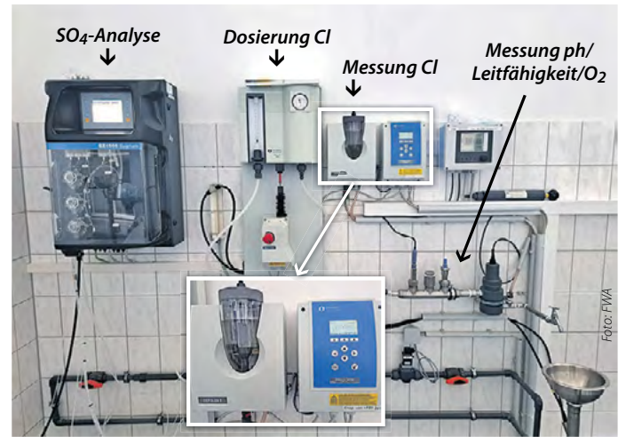
Die Qualität des Trinkwassers wird im Wasserwerk gebündelt an dieser Messstrecke überwacht. Der Sulfat-Analysator (links) arbeitet quasi wie ein vollautomatisches Labor, er nimmt zyklisch Proben und analysiert diese. Sulfat kann nicht kontinuierlich gemessen werden. Hinter den Reinwasserproben wird über separate Rohrleitungen stetig Probenwasser entnommen und durch verschiedene Armaturen geleitet. In den Armaturen befinden sich Sensoren für Sauerstoff, Leitfähigkeit und pH-Wert; die Temperatur wird als Nebenergebnis miterfasst (rechts). Parallel erfolgt die Messung der Konzentration an freiem Chlor, bei Bedarf wird es vor den Reinwasserpumpen ins Trinkwasser dosiert (Mitte).
