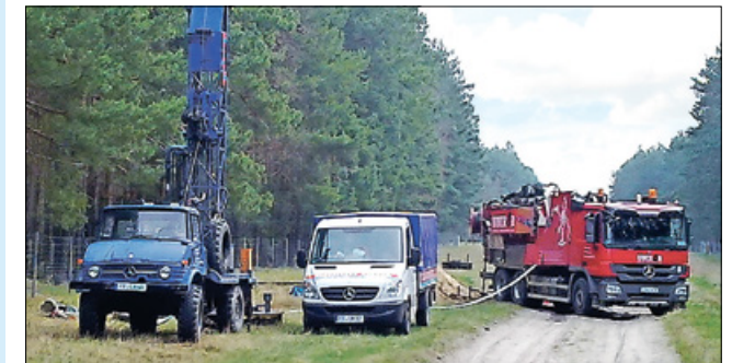
Mit Spezialtechnik von Brunnenbau Klebe und Bohrlochmessung Storkow konnte das „Problem hartnäckige Ablagerungen“ schnell, gründlich und umweltfreundlich gelöst werden.
