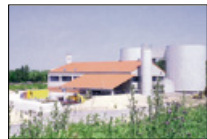
Die Schlammbehandlung der Frankfurter Kläranlage.
