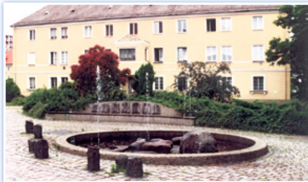
Der Springbrunnen wurde ohne schmückende Elemente und nur aus Natur- und Kunststein gebaut. Das Becken liegt fast ebenerdig, es ist aus Beton gegossen und hat einen Durchmesser von sechs Metern.
