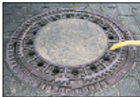
Beispiel für unerlaubtes Pumpen in einen Schmutzwasserschacht. Diese Schächte dienen jedoch nur Kontrollzwecken.
