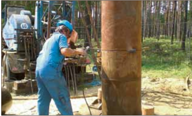
Jede einzelne Bohrröhlrlänge wurde von Mitarbeitern der Firma Pestke aufgesetzt und verschweißt.
