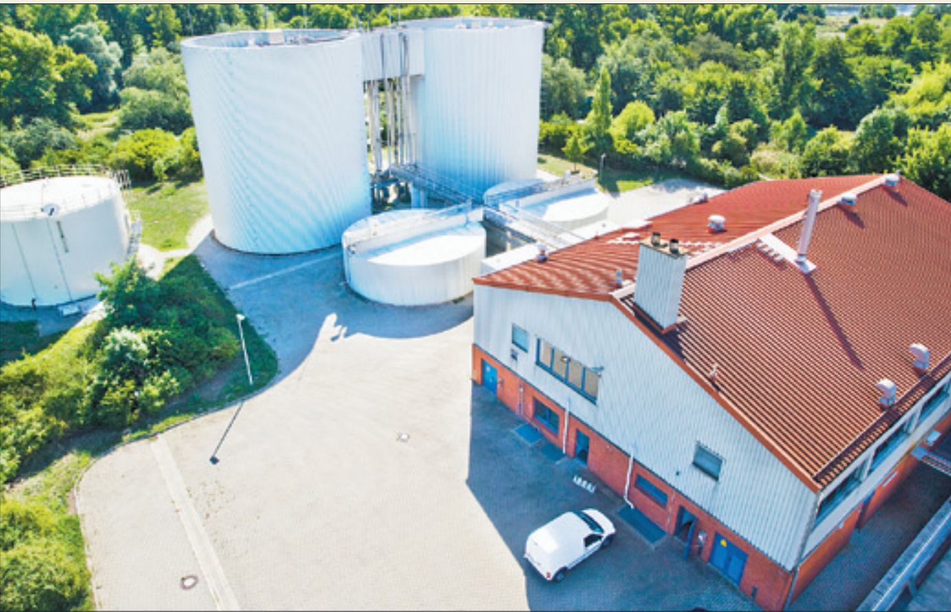
Die beiden Faultürme an der Kläranlage Frankfurt (Oder) wurden von Tauchern kontrolliert. Nun steht die Reinigung bevor.
