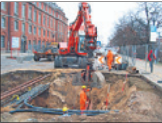
Baustelle Große Oderstraße.
