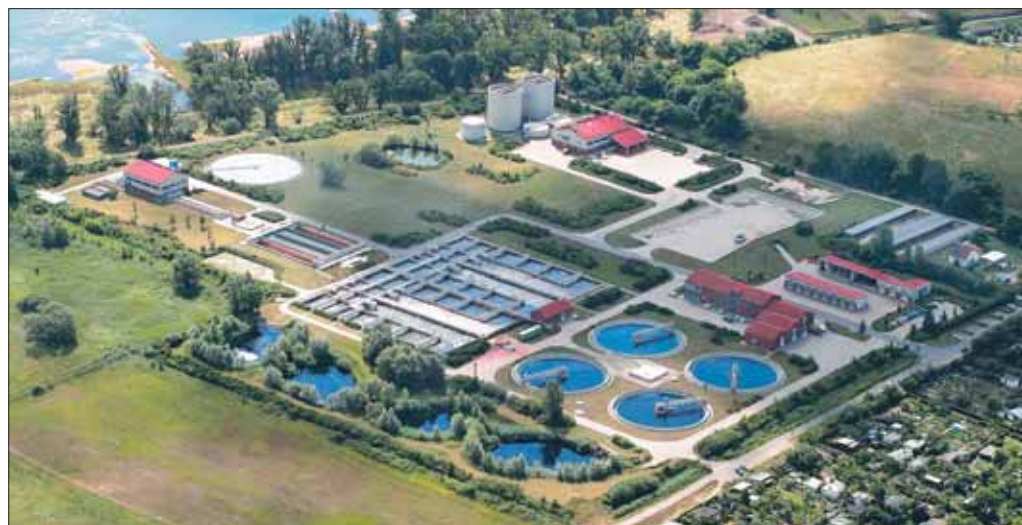
Die Kläranlage Frankfurt (Oder) steht am 22. März interessierten Besuchern offen.
