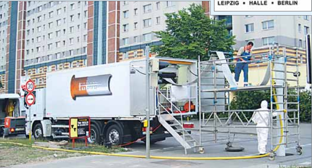
tubus-Kanalsanierung mittels Schlauchlining bei Eurawasser in Rostock.
