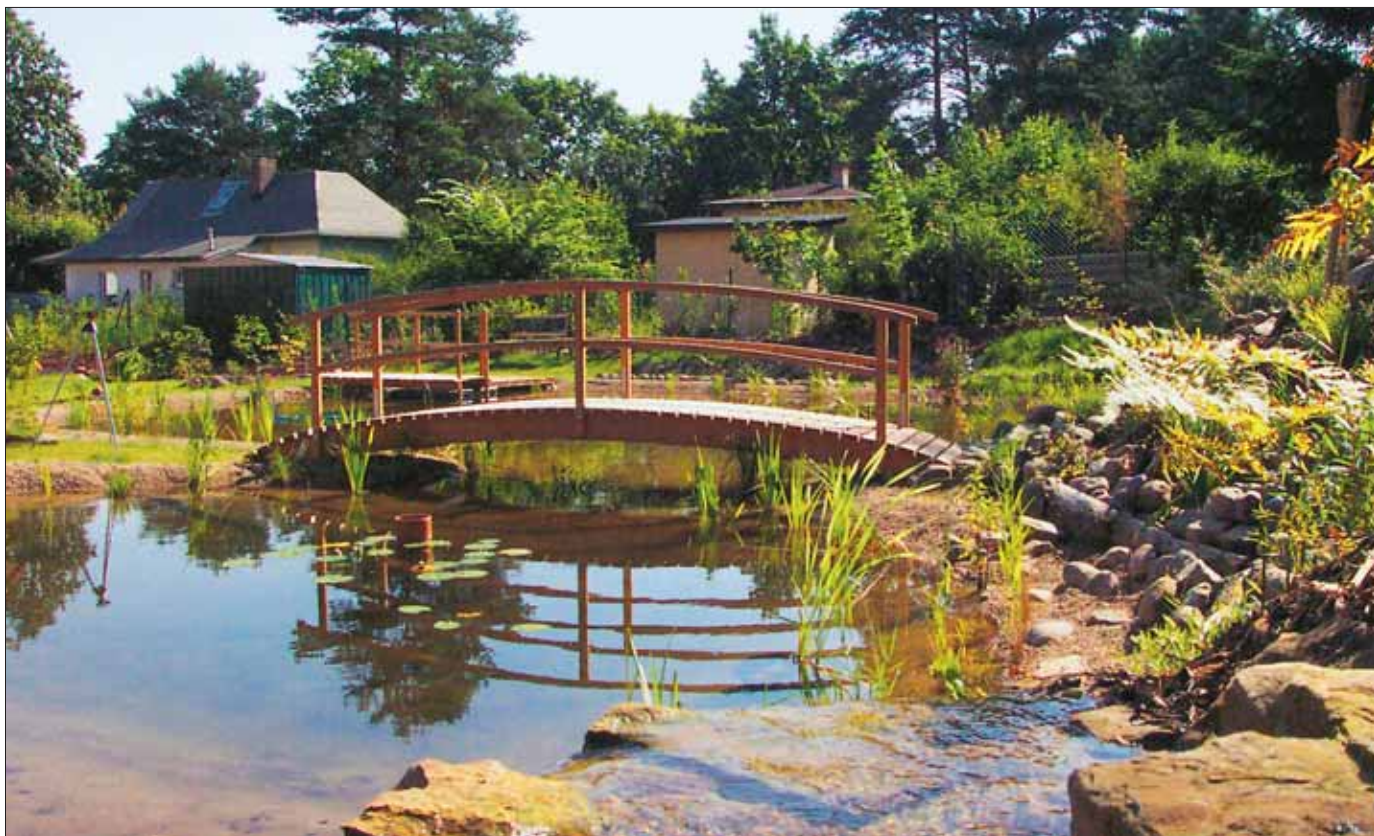
Ein von der Firma Re-natur Havelland geplanter und gebauter Schwimmteich.
