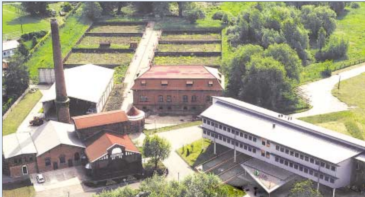
Im Buschmühlenweg, wo sich Altes und Neues vereinen, ist seit über 100 Jahren die Wasserwirtschaft zu Hause.
