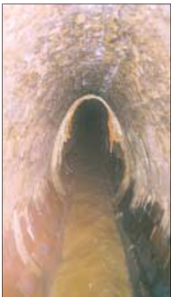
Der Kanal vor der Sanierung.
