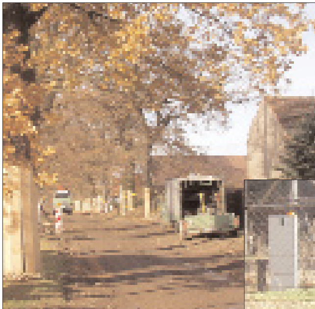
Ganz Pagram ist jetzt ans zentrale Abwassernetz angeschlossen. Kleines Foto: Hauspumpwerk.
