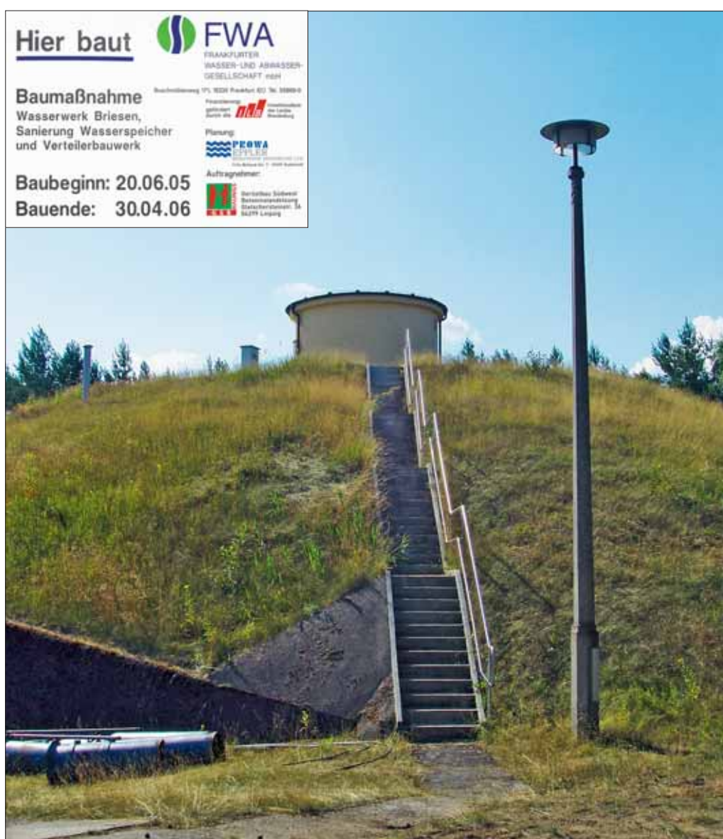
Bereits sanierter Wasserspeicher I im Wasserwerk Briesen.
