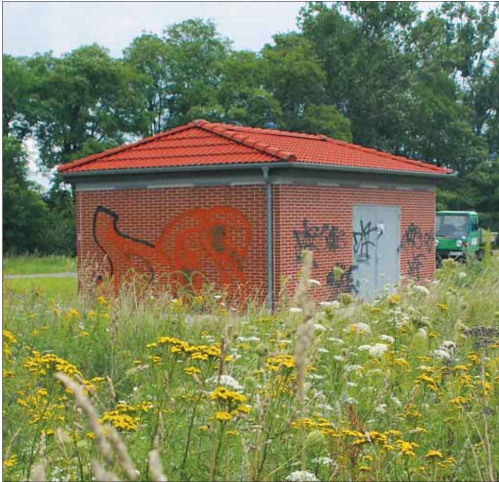
Das Pumpwerk am Lehmweg in Markendorf-Siedlung.
