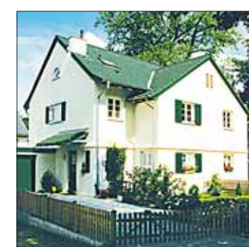
Mit dem Hausanschluss ist der Neubau dann komplett.
