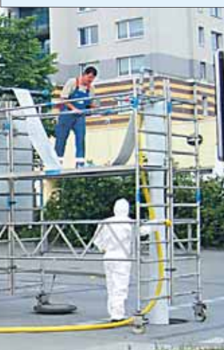
tubus-Kanalsanierung mittels Schlauchlining bei Eurawasser in Rostock.
