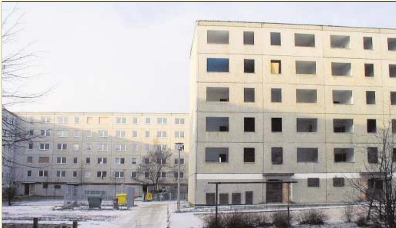
Ein gespenstischer Anblick: leergezogene Plattenbauten in der Willichstraße warten auf den Abriss.
