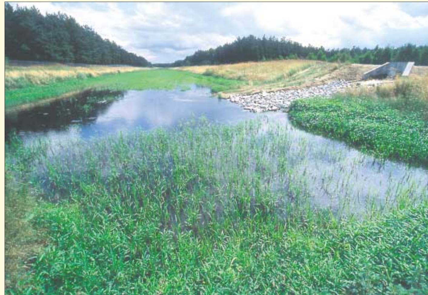
Bei Briesen wird der Spree das Wasser für die Uferfiltration entnommen. Rechts das Einlaufwerk.
