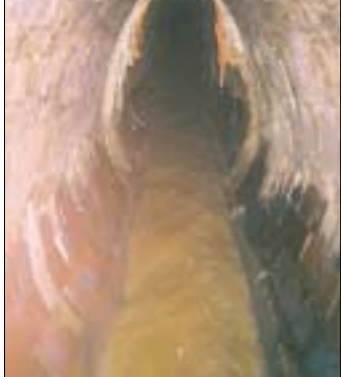
Der Kanal vor der Sanierung.
