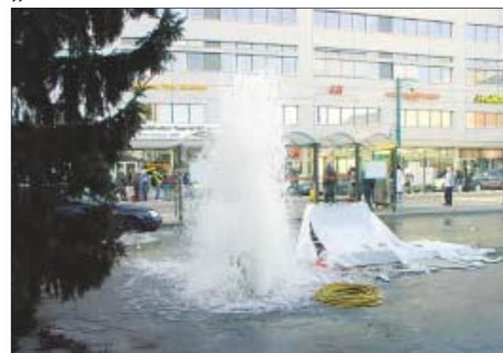
Kein neues Wasserspiel für die Innenstadt, sondern ein Rohrbruch im Dezember 2002 vor dem Oderturm in Frankfurt.
